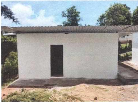
Foto 1: Vista Exterior de Cocina, se observa cernido finalizado, chimenea, colocación de lámina y banqueta realizada.
