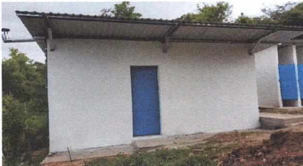
Foto 3: Vista Exterior de Cocina, se observa la instalación de puerta en cocina y se logra apreciar la instalación de puertas en S.S.
