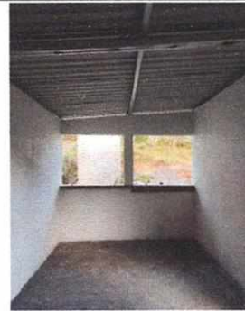
Foto 4: Vista Interior de Cocina, se observa la mejora en las condiciones del techo a través del cambio de lámina
