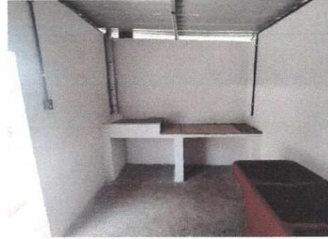
Foto 2: Vista Interior de Cocina, Se observa trabajos finalizados en mesa de trabajo fundida, estufa mejorada finalizada, cernido interior e instalación de energía eléctrica luz y fuerza
