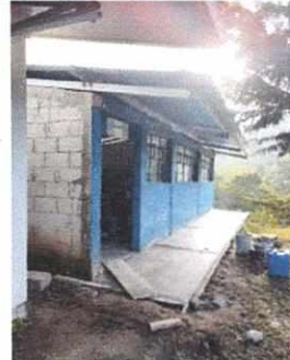
Foto 6: Vista Exterior de Aula, se observa la fundición finalizada de banqueta frente a aula de primaria
