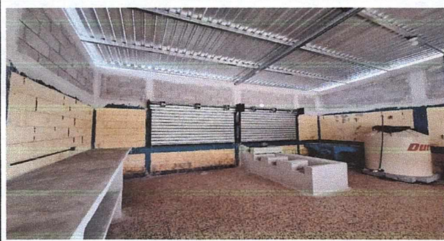
Foto 3: Mejoramiento de Cocina Modulo I
