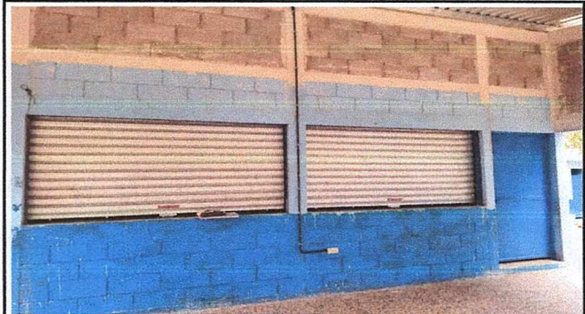
Foto 2: Mejoramiento en Aula (ventana) Modulo 2
