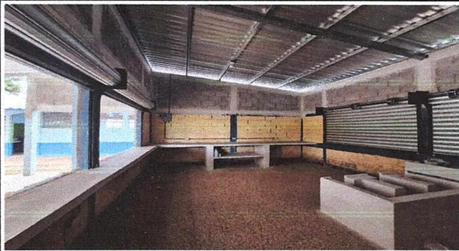
Foto1: Mejoramiento de Cocina Modulo I
