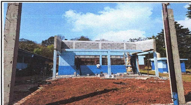
Foto1: Mejoramiento de Cocina Modulo I
