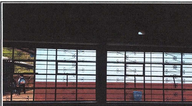
Foto 2: Mejoramiento en Aula (Ventanas)
