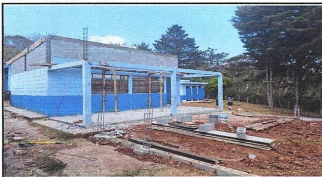
Foto 3: Mejoramiento de Cocina Modulo I
