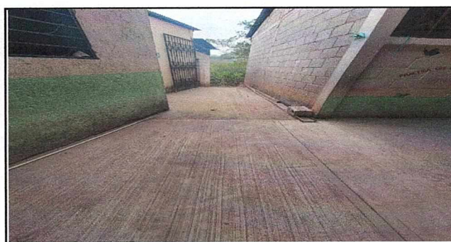
Foto 5: SE TERMINO EL CAMBIO DE LA TORTA DE CEMENTO
