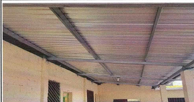
Foto 2: LA INSTALACION DEL TECHO YA TERMINADA.
