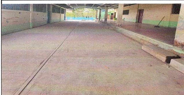
Foto1: TORTA DE CEMENTO DEL PATIO PRINCIPAL YA ESTA TERMINADA.
