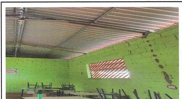
Foto 4: LA INSTALACION ELECTRICA ESTA TERMINADA.
