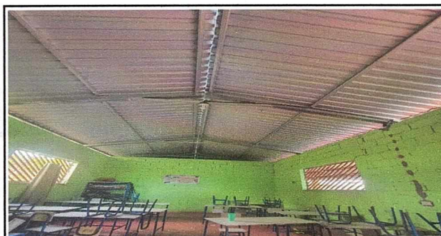
Foto 3: EL TECHO DE LAS AULAS ESTA TERMINADO
