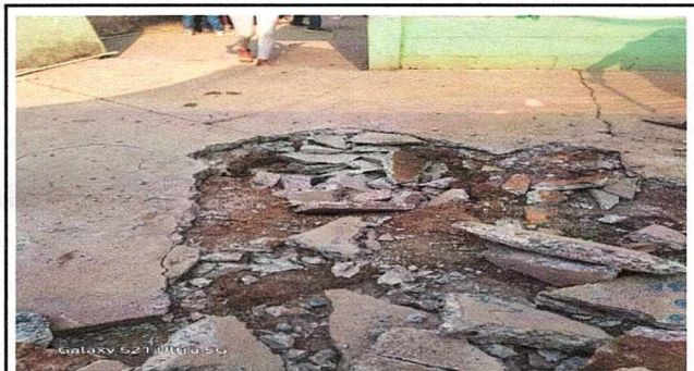
Foto 3: SE CONTINUAN LOS TRABAJOS DE LEVANDO DE TORTA DE CEMENTO
