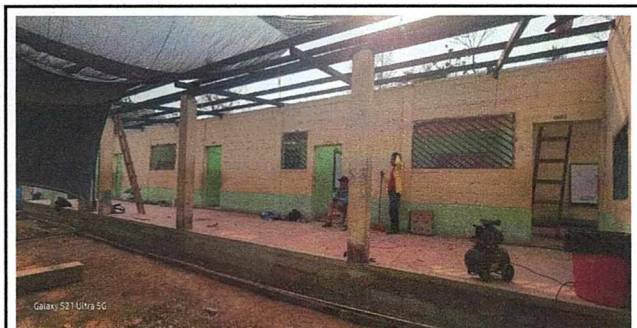
Foto 5: EN ESTA PARTE YA SE HABIA QUITADO EL TECHO Y LA TORTA DE CEMENTO ES SU TOTALIDAD
