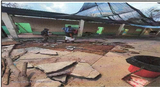
Foto 1: SE ESTABA LEVANTANDO LA TORTA DE CEMENTO DEL PATIO
