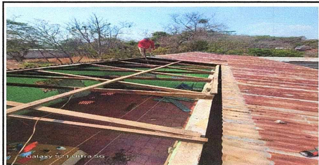
Foto 2: SE ESTABA RETIRANDO LA LAMINA DE LAS AULAS AFECTADAS
