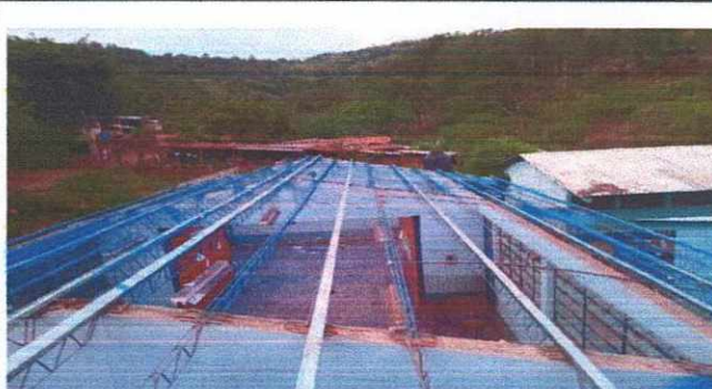
Foto 2 Sustitucion del techo
