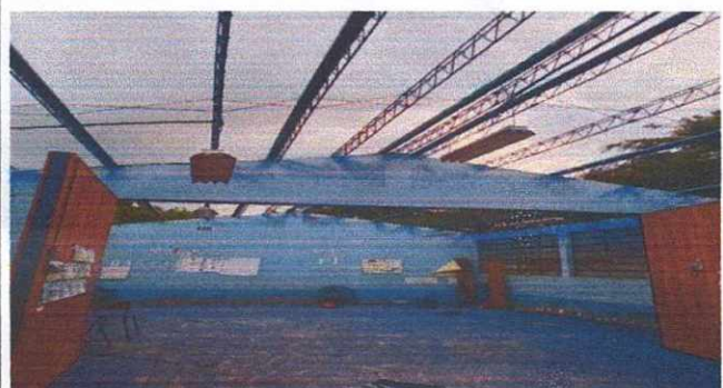
Foto 3 Reparacion de Techo
