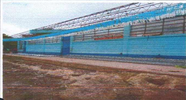
Foto 1: Modulo de Escuela Oficial Rural Mixta Caserío Enramadas, Cantón Valencia
