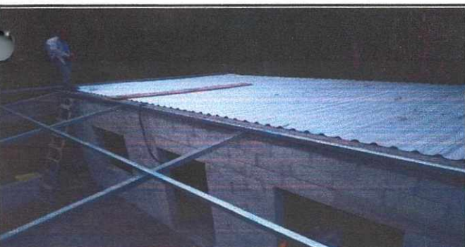
Foto 5 remodelacion de la cocina
