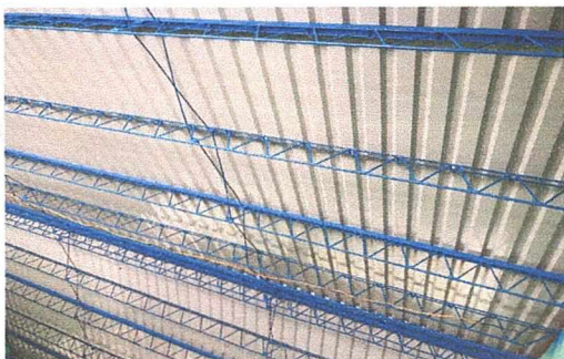
Foto 3: Estado Final de la estructura de soporte tipo Joist con refuerzo tubo en módulo 1.
