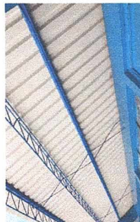
Foto 2: Estado final techo con lámina en corredor del módulo de aulas de la uno a la tres.
