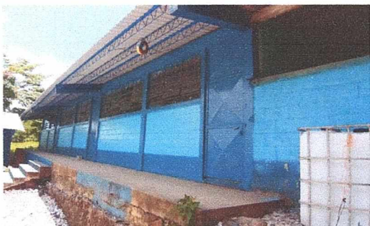
Foto 1: Estado Final del módulo 1 de aulas a intervenidas, mejoramiento de techo.
