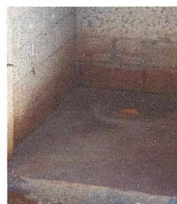
FOTO 10: Drenaje para preparado para inodoro lavable en servicio sanitario 6
