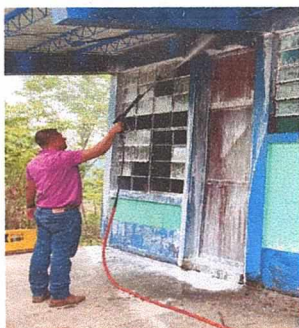
Foto 11: Limpieza de ventana previo a la instalación de vidrios en ventana de cocina.
