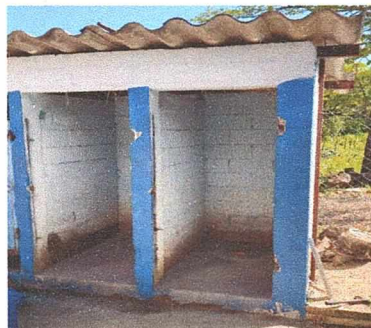
Foto 8: Área limpiara para colocación de piso y azulejo en servicio sanitario 6.
