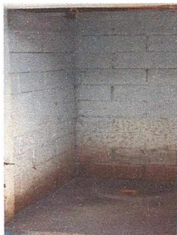
FOTO 9: Base para instalación piso en servicio sanitario 6 preparada.
