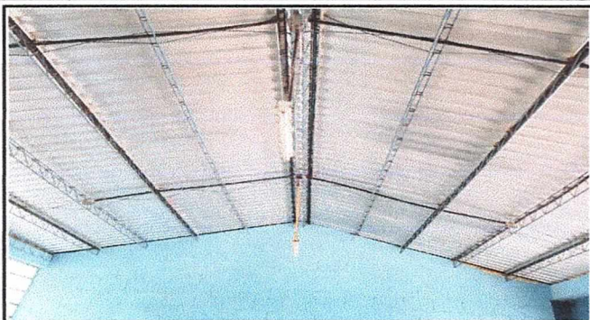
Foto 1: Techo de lámina instalada en las aulas del establecimiento
