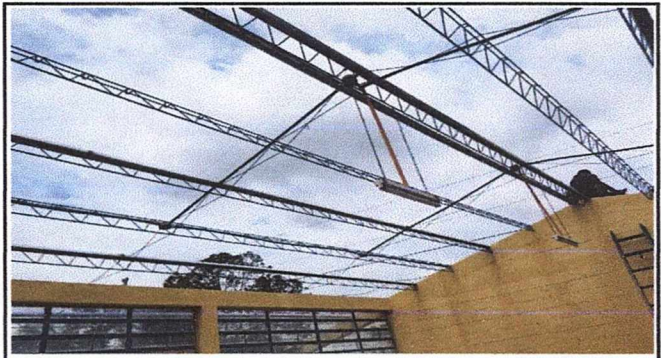
Foto 2: Colocación de Costaneras
