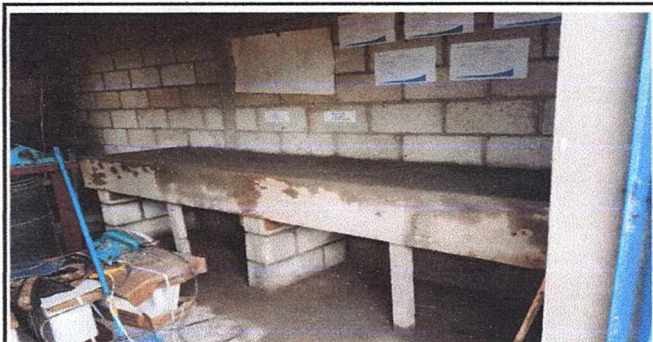
Foto 5: Fundición mesa de concreto para cocina.
