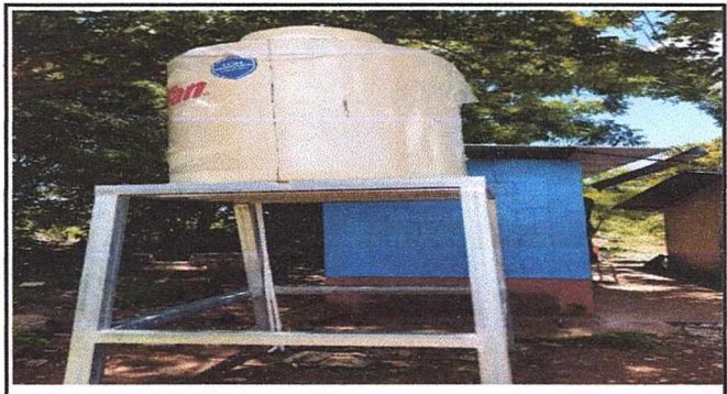
Foto 4: Instalación de tinaco
