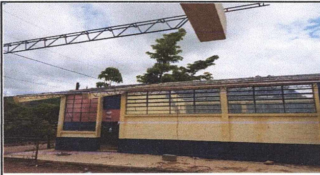
Foto 1: Desmontado de duralita
