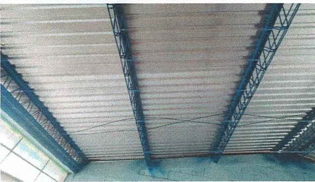
Foto 3: Lado principal, lado derecho, terminado
