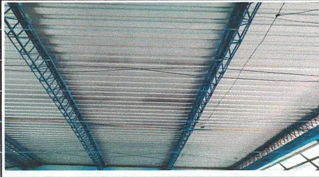
Foto 2: lado inferior izquierdo terminado
