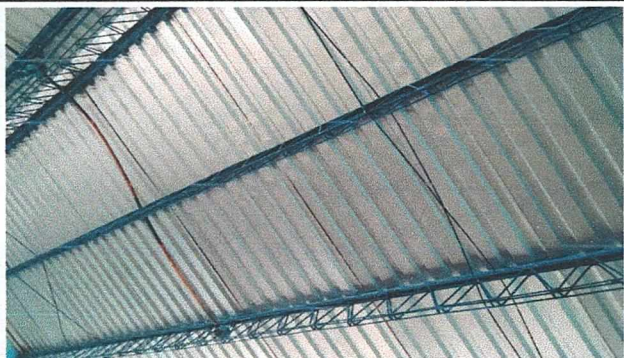
Foto1: Lado derecho parte superior terminado.
