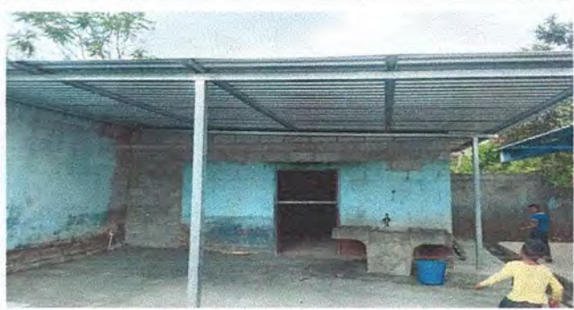
Foto 4: Techo y fachada terminados
