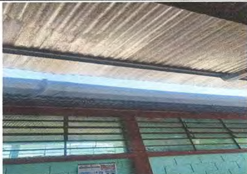
Foto 1. Sustrucción de Canales
