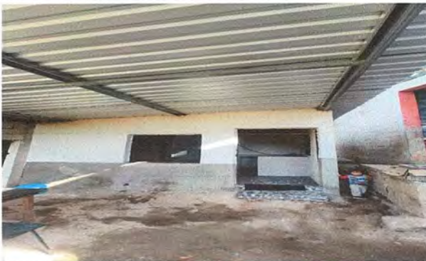
Foto 9. cambio de techo en cocina
