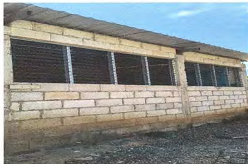
Foto 2: Colocación de ventanas sol-aire
