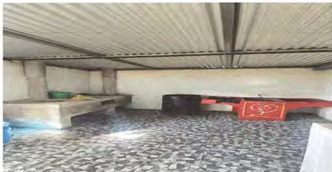
foto 13. colocación de piso en cocina y bodega
