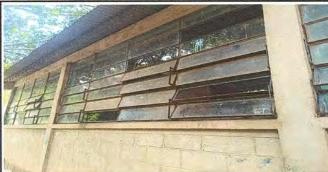
Foto 6: Colocación de Vidrios
