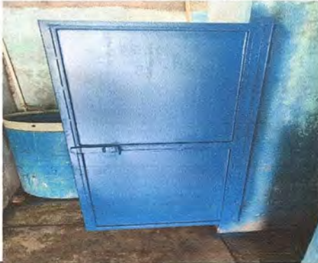
Foto 7: Reparación y pintura de puertas
