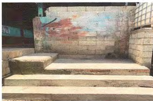
Foto 4: Reparación de Gradas
