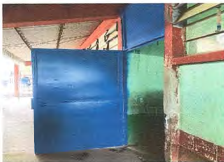
Foto 5: Reparación y Pintura de puertas
