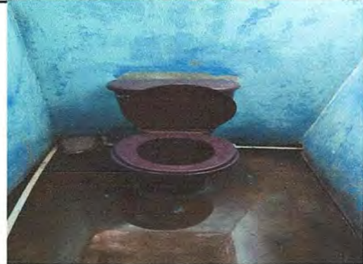
Foto 8. Cambio de Sanitarios
