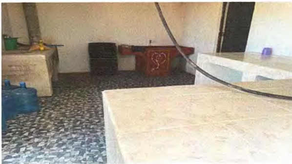
Foto 11. construcción de polleton, mesa de cemento
