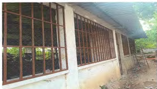
Foto 3: Colocación de balcones de metal en ventana
