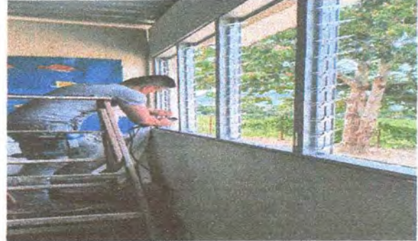
Foto 2: Colocación de ventanas sol-aire
