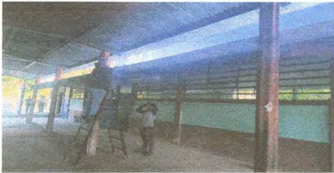
Foto 1: Sustitución de Canales
