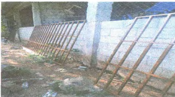
Foto 3: Colocación de balcones de metal en ventana
