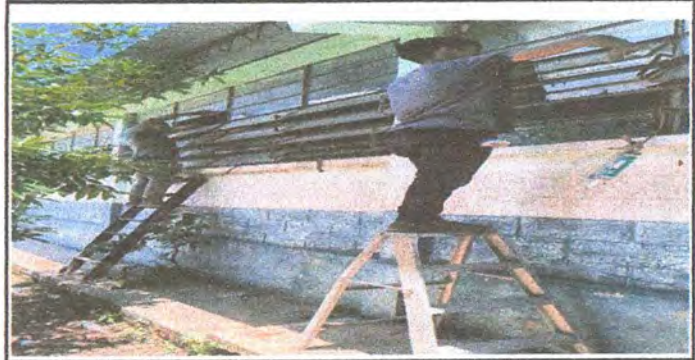
Foto 6: Colocación de Vidrios
