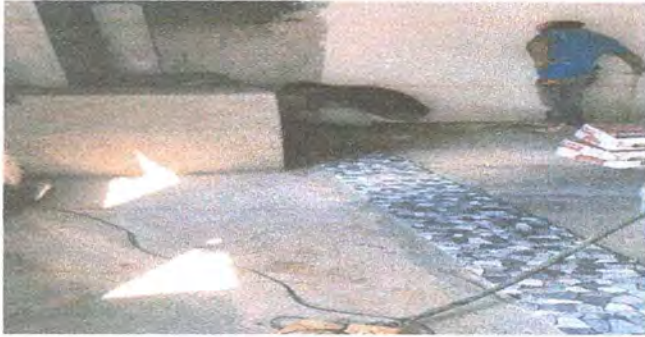
Foto 13. colocación de piso en cocina y bodega
