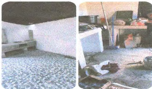
Foto 11. construcción de polleton, mesa de cemento
