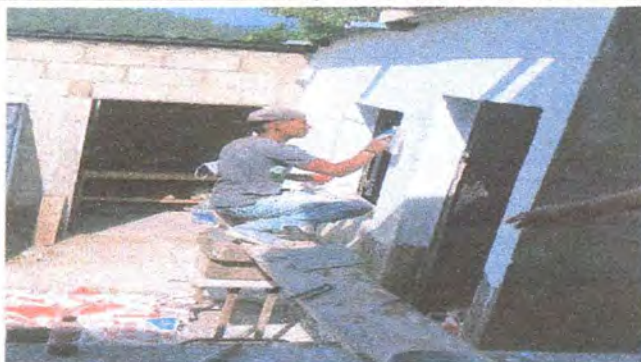
Foto 10. Repello de cocina y bodega
