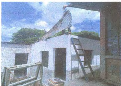
Foto 9. cambio de techo en cocina
