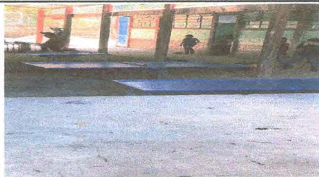
Foto 5: Reparación y Pintura de puertas
