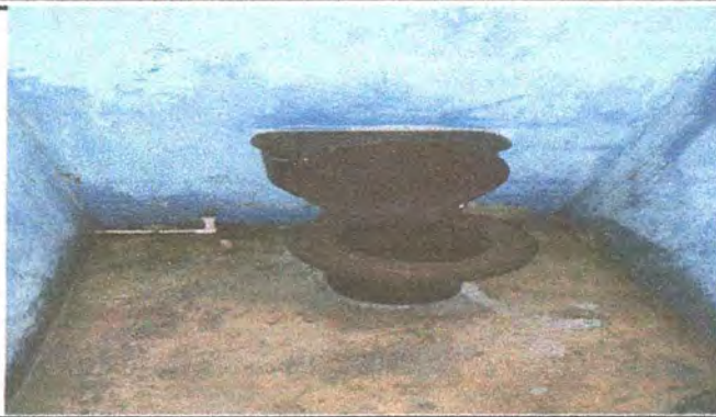
Foto 8. Cambio de Sanitarios
