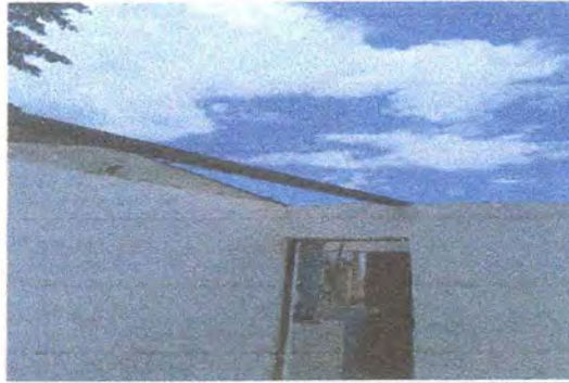
Foto 12. Cambio de techo en bodega
