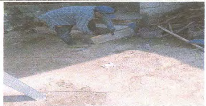
Foto 4: Reparación de Gradas
