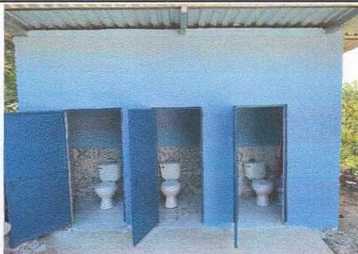
Foto 7: remozamiento de baños, mejoramiento de lavamanos, instalación de torta de concreto, pintura interior y exterior, remozamiento e instalación de puertas.
