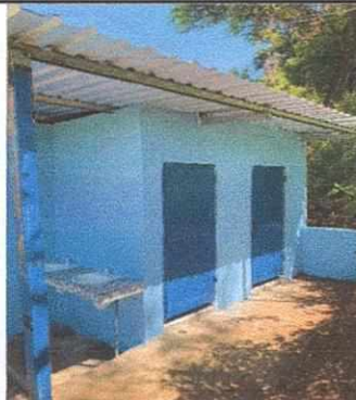
Foto 8: Ampliación de paredes para ampliación de módulo de baños, instalación de inodoros, puertas, piso de torta de concreto.
