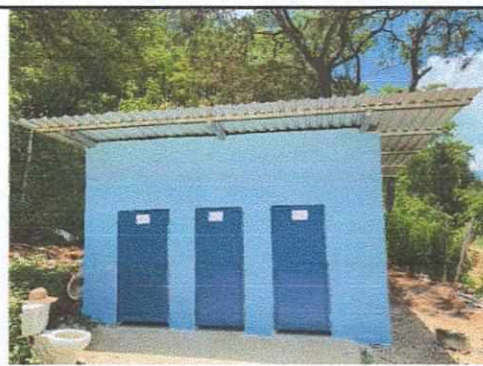
Foto 6: Remozamiento de baños con ampliación de muros, instalación de inodoros, azulejo, piso cerámico.
