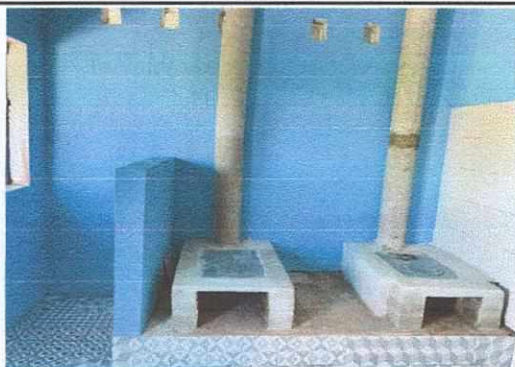
Foto 3: Suministro e instalación de estufa rural completa con chimenea y parrilla de metal.
