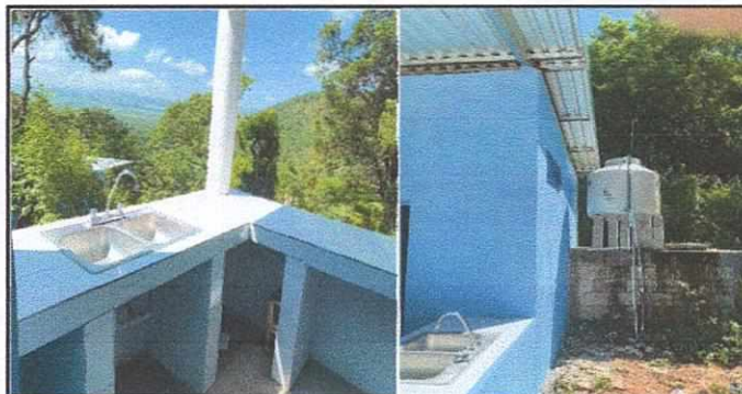
Foto 12: Instalacion de azulejo, lavatrastos con accesorios y deposito de agua con sus accesorios y tuberia .
