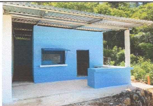
Foto 2: Ampliación y remodelación cocina, instalación de pila, torta de concreto, cernido de muros, lavatrastos, pintura, mejoramiento de ventana.
