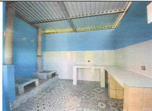
Foto 4: Ampliación de alto de pared de fondo para aislar el calor, instalación de ventana, instalación de piso cerámico, azulejo, cernido y pintura en cocina.
