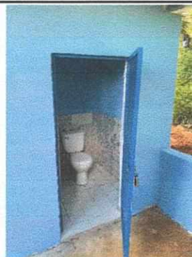
Foto 10: Amliación y mejoramiento de módulo de baños.
