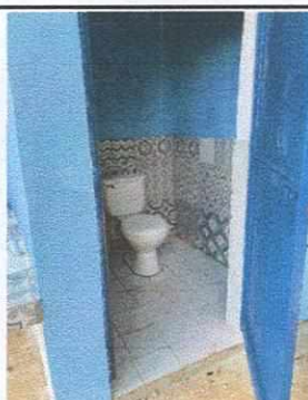
Foto 11: suministro e instalación de piso cerámico y azulejo en sanitarios.
