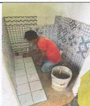
Foto 11: suministro e instalación de piso cerámico y azulejo en sanitarios.
