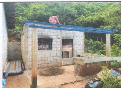
Foto 5: Sustitución de techo para cocina.
