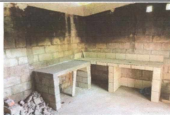
Foto 4: Ampliación de alto de pared de fondo para aislar el calor, instalación de piso cerámico, azulejo, cernido y pintura en cocina.
