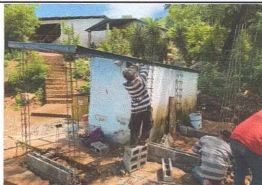
Foto 8: Ampliacion de paredes para ampliacion de módulo de baños , instalación de inodoros, puertas, piso de torta de concreto.
