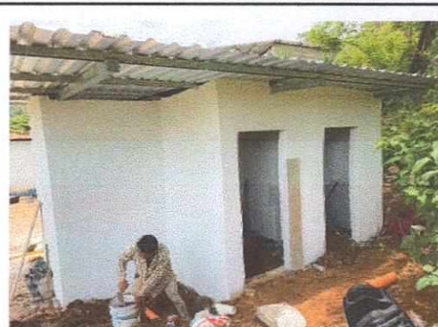
Foto 10: Amliación y mejoramiento de módulo de baños.
