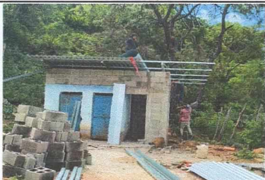
Foto 7: remozamiento de baños, mejoramiento de lavamanos, instalación de torta de concreto, pintura interior y exterior, remozamiento e instalacion de puertas.
