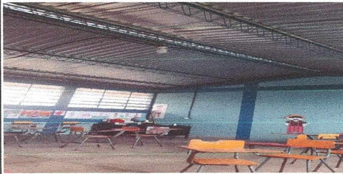
Foto 6: Arreglo de techado
