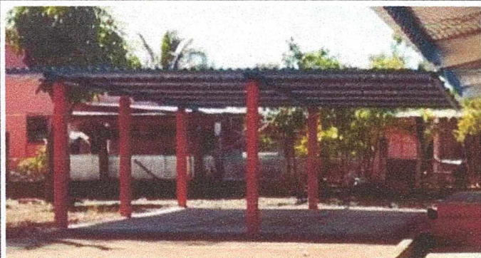
Foto 1: Arreglo de techado
