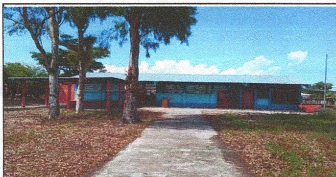
Foto 3: Arreglo de techado
