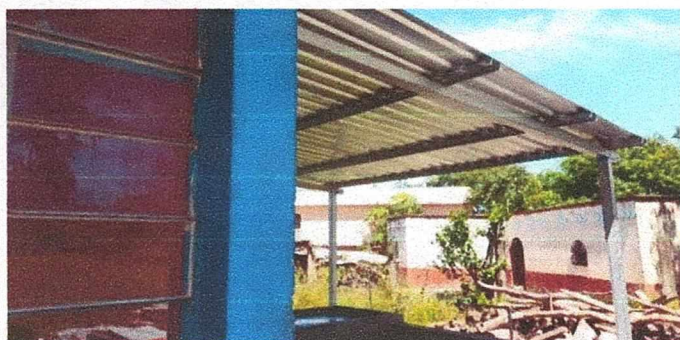
Foto 5: Arreglo de techado
