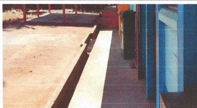
Foto 2: Arreglo de losa de patio
