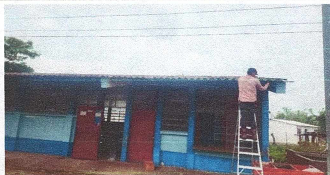
Foto 2: Reparación de techado
