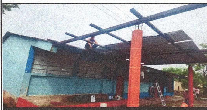
Foto 1: Reparación de techado
