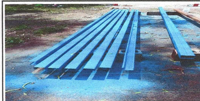
Foto 5: Reparación de vigas
