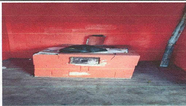
Foto 4: Reparación de orno
