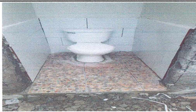
Foto 4: SUSTITUCIÓN DE LETRINAS POR BAÑOS LAVABLES Y SUSTITUCIÓN DE MINGITORIO
