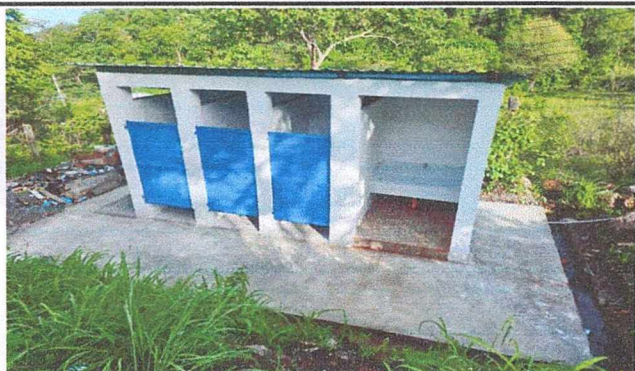
Foto 3: SUSTITUCIÓN DE TECHO CON DURALITA Y POR LÁMINA TROQUELADA, MEJORAMIENTO DE FOSA SEPTICA, PAREDES Y PUERTAS METALICAS E INSTALACIÓN DE TUBERIA PARA DRENAJE EN SANITARIOS
