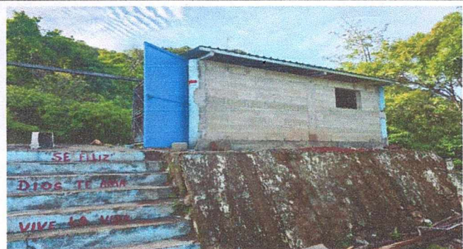
Foto 5: SUSTITUCIÓN DE TECHO CON ESTRUCTURA METÁLICA Y LÁMINA TROQUELADA, MEJORAMIENTO EN AREA DE COCINA
