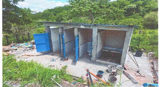
Foto 2: SUSTITUCIÓN DE TECHO CON DURALITA Y POR LÁMINA TROQUELADA, MEJORAMIENTO DE FOSA SEPTICA, PAREDES Y PUERTAS METALICAS E INSTALACIÓN DE TUBERIA PARA DRENAJE EN SANITARIOS
