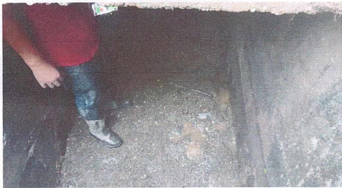
Foto 3: SUSTITUCIÓN DE TECHO CON DURALITA Y POR LÁMINA TROQUELADA, MEJORAMIENTO DE FOSA SEPTICA, PAREDES Y PUERTAS METALICAS E INSTALACIÓN DE TUBERIA PARA DRENAJE EN SANITARIOS
