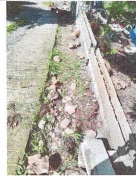
Foto 6: REPARACIÓN DE MURO PERIMETRAL DE BLOCK CON TUBO HG Y MALLA GALVANIZADA, SOLERAS INTERMEDIAS Y COLUMNAS
