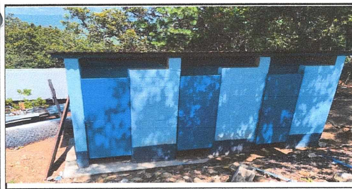
Foto 5. Mejoramiento de baños
