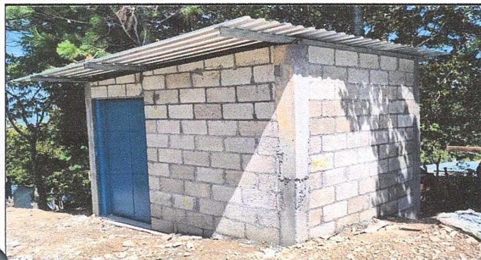
Foto 1. Mejoramiento de cocina
