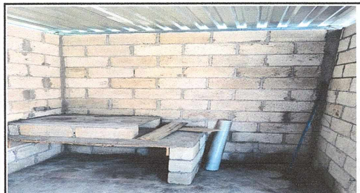
Foto 3. Instalacion de estufa rural, con torta de concreto
