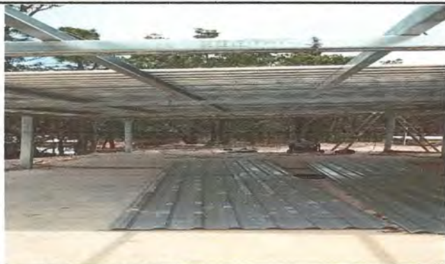
Foto 7. instalacion de techo para ualas
