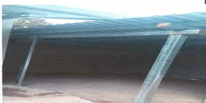
Foto 6. Reparacion de techo para aulas
