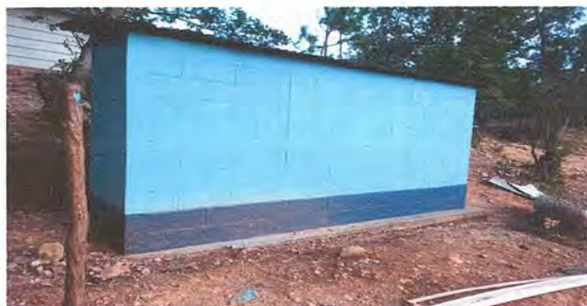
Foto 10. pintura de pared para los baños
