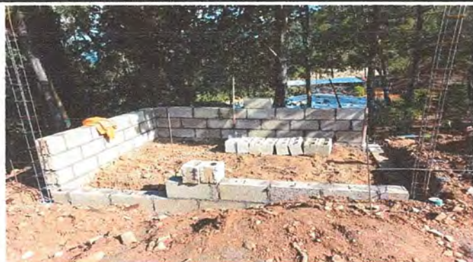
Foto 1. Levantamiento de paredes de mamposteria en cocina
