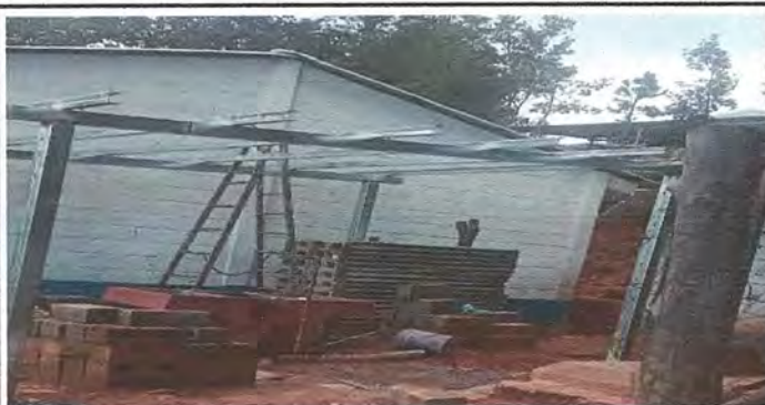
Foto 3. Mejoramiento galera para patio de cocina
