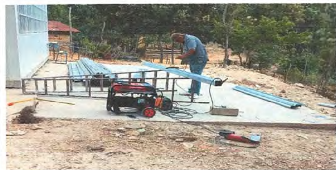
Foto 5. Mejoramiento de aulas
