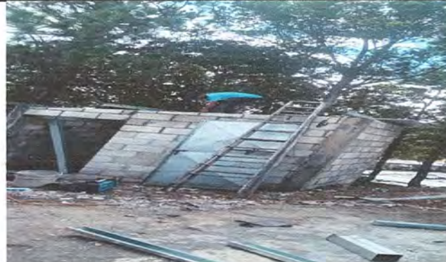
Foto 2. Reparacion de techo de cocina
