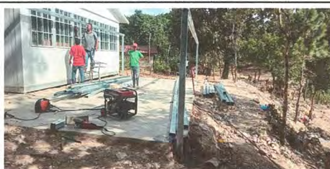
Foto 8. Base para paredes de lamina para aulas
