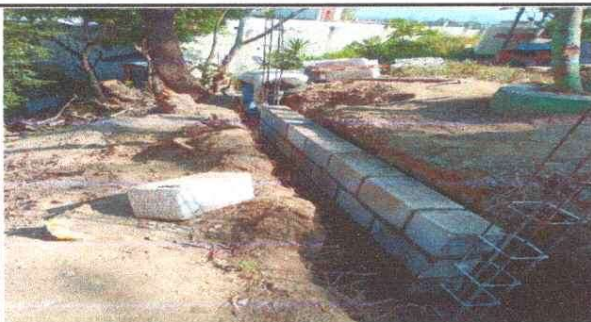
Foto 3: Mejoramiento muro perimetral
