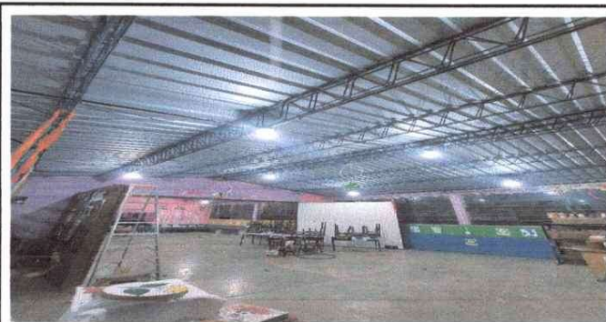
Foto 5: Remozamiento sistema eléctrico
