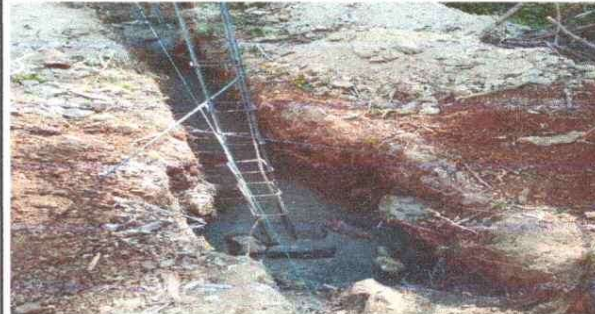
Foto 2: Mejoramiento de muro perimetral
