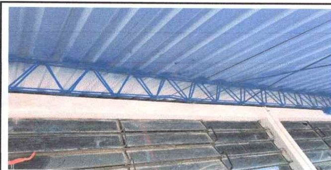
Foto 3: Remozamiento de estructura
