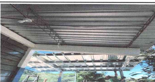
Foto 4: Remozamiento de techo
