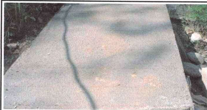
Foto 1: Remozamiento de losa
