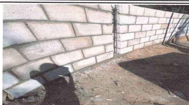
Foto 2: Remozamiento de muro
