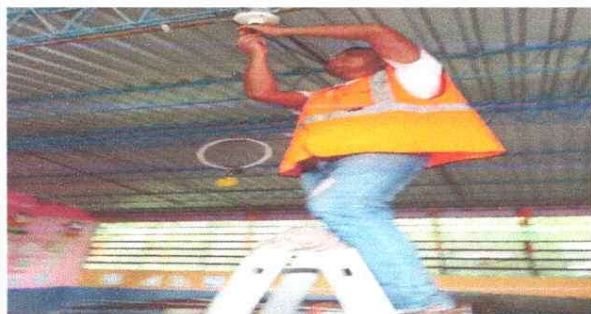
Foto 1: Mejoramiento sistema electrico
