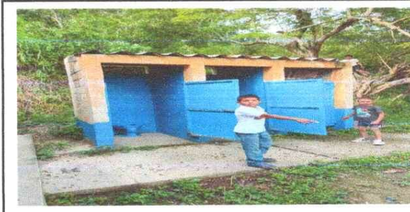
Foto 6: Mejoramiento de baños
