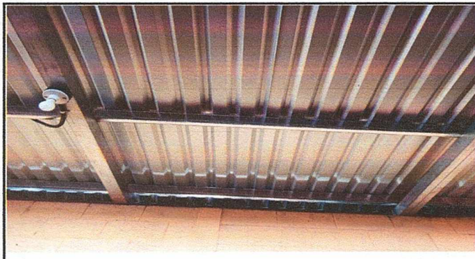
Foto 2: Culminacion de colocacion de techo interno
