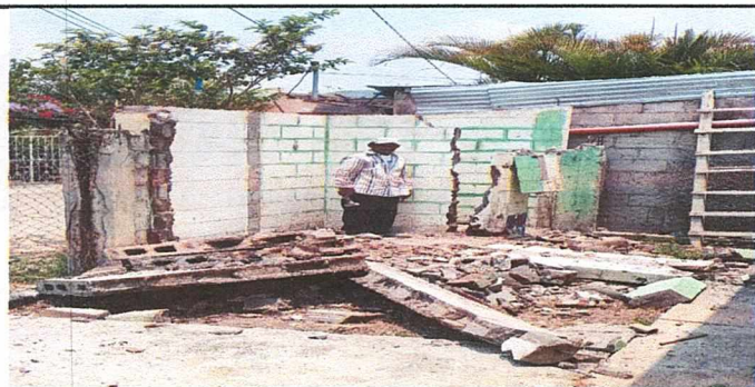
Foto 5: Remodelacion de baños
