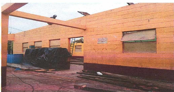
Foto 3: Arreglo de techo interno
