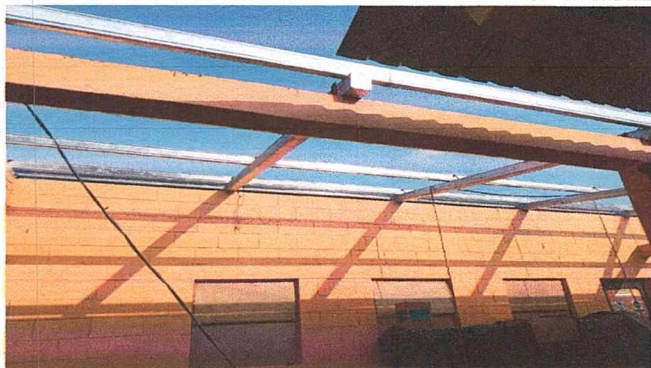
Foto 1; Arreglo de techo interno
