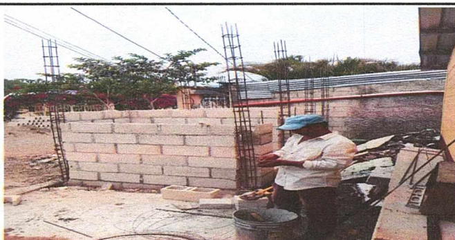
Foto 6: Remodelacion de baños avance
