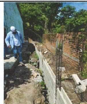
Foto 10: REPARACIÓN Y MEJORAMIENTO DE MURO PERIMETRAL
