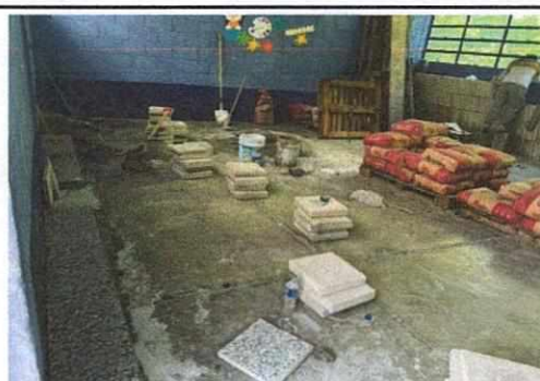
Foto 4: SUSTITUCIÓN DE PISO DE CONCRETO POR PISO DE GRANITO
