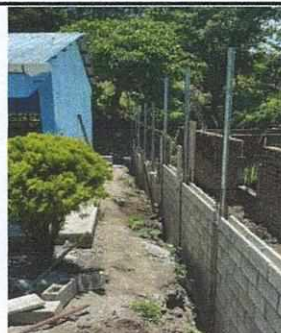
Foto 11: REPARACIÓN Y MEJORAMIENTO DE MURO PERIMETRAL
