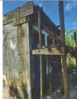
Foto 8: MEJORAMIENTO DE SERVICIOS SANITARIOS
