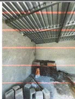
Foto 2: SUSTITUCIÓN TECHO, MEJORAMIENTO DE PAREDES, MEJORAMIENTO DE ESTUFA RURAL, SUSTITUCIÓN DE PISO DE CONCRETO, MEJORAMIENTO DE PUERTA Y ESTRUCTURA DE METAL DE VENTANA EN AREA DE COCINA
