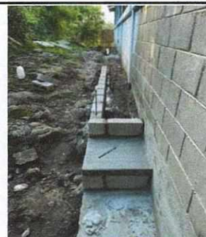
Foto 6: REPARACIÓN DE TORTA DE CONCRETO
