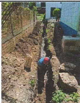
Foto 9: REPARACIÓN Y MEJORAMIENTO DE MURO PERIMETRAL
