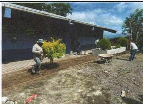
Foto 5: REPARACIÓN DE TORTA DE CONCRETO
