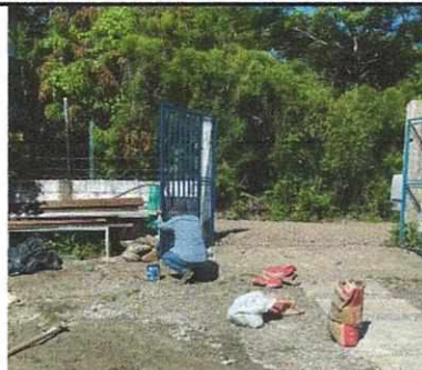
Foto 12: MEJORAMIENTO DE PORTÓN PRINCIPAL
