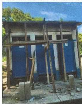
Foto 7: MEJORAMIENTO DE SERVICIOS SANITARIOS
