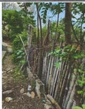
Foto 9: REPARACIÓN Y MEJORAMIENTO DE MURO PERIMETRAL
