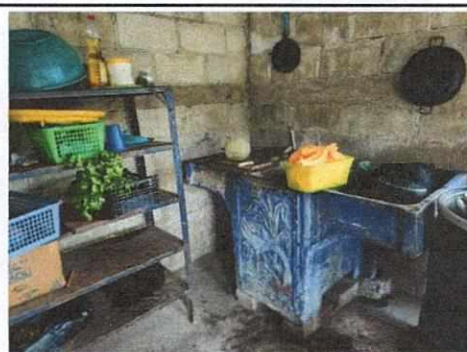
Foto 4: SUSTITUCIÓN DE TUBERIA PVC PARA AGUA POTABLE Y SUSTITUCIÓN DE PILA
