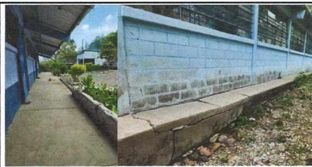
Foto 6: REPARACIÓN DE TORTA DE CONCRETO
