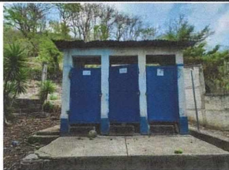
Foto 8: MEJORAMIENTO DE SERVICIOS SANITARIOS
