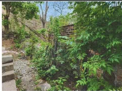
Foto 10: REPARACIÓN Y MEJORAMIENTO DE MURO PERIMETRAL
