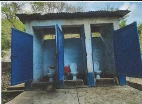
Foto 7: MEJORAMIENTO DE SERVICIOS SANITARIOS
