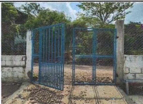
Foto 11: MEJORAMIENTO DE PORTÓN PRINCIPAL
