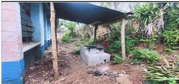
Foto 7. Techo de cocina
