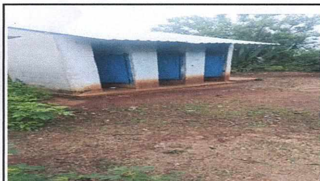
Foto 11. Paredes y losa para fosa séptica
