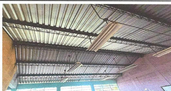
Foto 4: Techo del modulo 2 en optimas condiciones.
