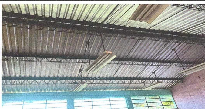
FOTO 3: Techo del modulo 2 terminado
