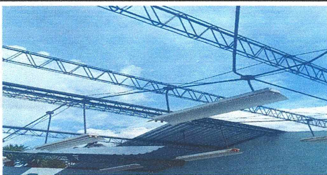
Foto 3: Techo de modulo 2 cambiandose.
