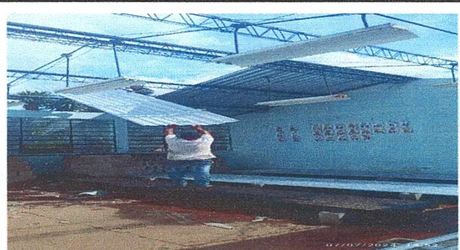
Foto 4: Techo del modulo 2 en cambios.
