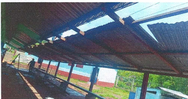
Foto 5: Cambio de techo del corredor.
