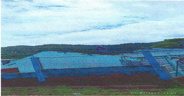
Foto 1: Vista de techo en mejoramiento.
