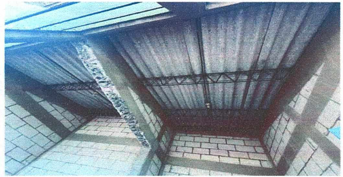
Foto 2: Vista de techo de modulo 5 cambiandose.
