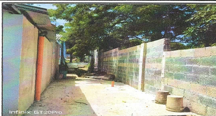
Foto 2: MEJORAMIENTO MURO PERIMETRAL
