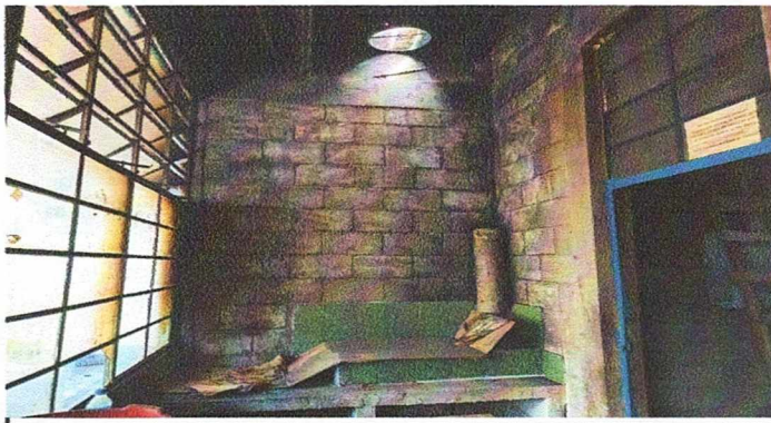
Foto 4: MEJORAMIENTO DE LA COCINA
