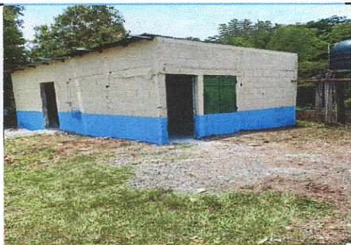
Foto 3: Levantamiento de pared y reconstruccion de techo
