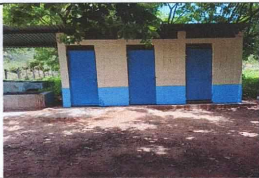
Foto 5: mejoramiento de puertas
