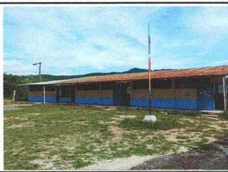
Foto 6: Pintura de muros exteriores
