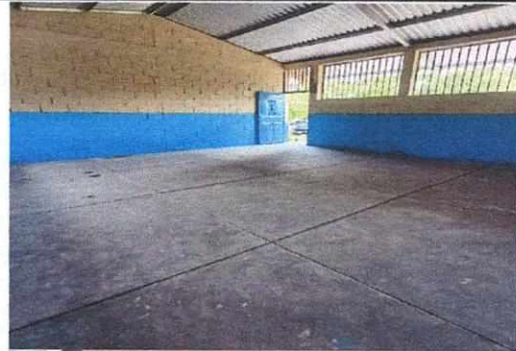
Foto 2: Colocacion de torta de cemento
