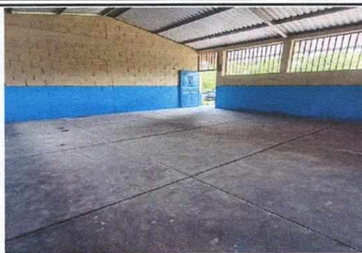
Foto 2: Colocacion de torta de cemento
