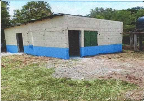
Foto 3: Levantamiento de pared y reconstruccion de techo
