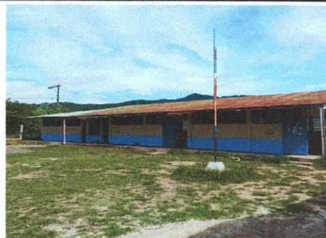
Foto 6: Pintura de muros exteriores
