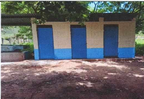
Foto 5: mejoramiento de puertas
