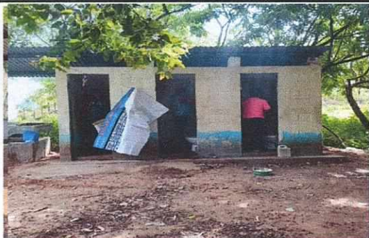
Foto 5: mejoramiento de puertas
