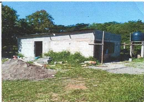
Foto 3: Levantamiento de pared y reconstruccion de techo
