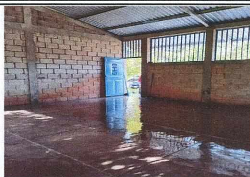
Foto 2: Colocacion de torta de cemento
