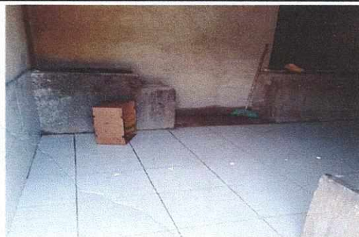
Foto 4: Sustitucion de piso
