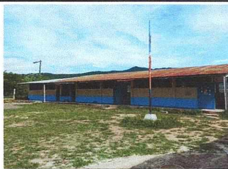
Foto 6: Pintura de muros exteriores
