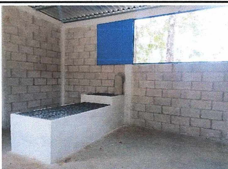
Foto 3: Interior cocina, lado izquierdo.
