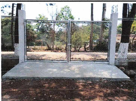
Foto 4: Parte lateral, portón en muro perimetral
