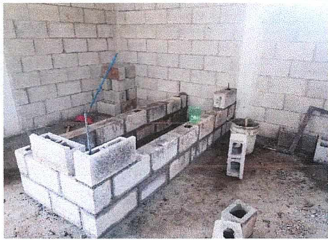
Foto 3: Interior cocina, lado izquierdo.
