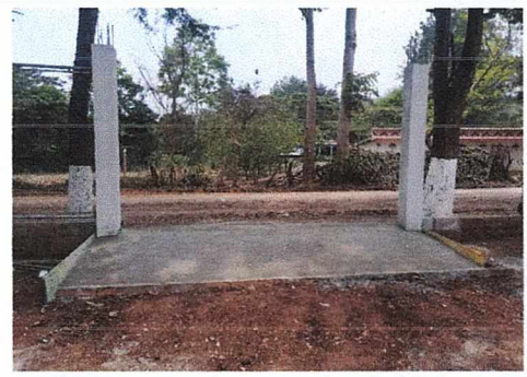
Foto 4: Parte lateral, muro perimetral.
