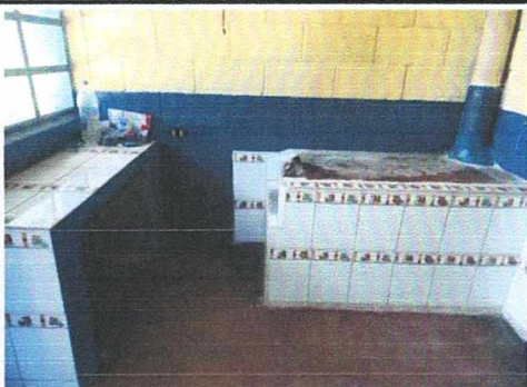
Foto 5: SUSTITUCIÓN DE ESTUFA RURAL CON CHIMENEA, PLANCHA DE METAL E INSTALACIÓN DE AZULEJO EN AREA DE COCINA
