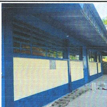
Foto 9: SUSTITUCIÓN DE VIDRIOS
