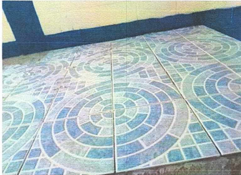
Foto 7: SUSTITUCIÓN DE TORTA DE CONCRETO POR PISO CERÁMICO
