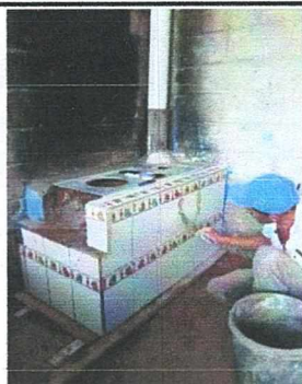
Foto 5: SUSTITUCIÓN DE ESTUFA RURAL CON CHIMENEA, PLANCA DE METAL E INSTALACIÓN DE AZULEJO EN AREA DE COCINA
