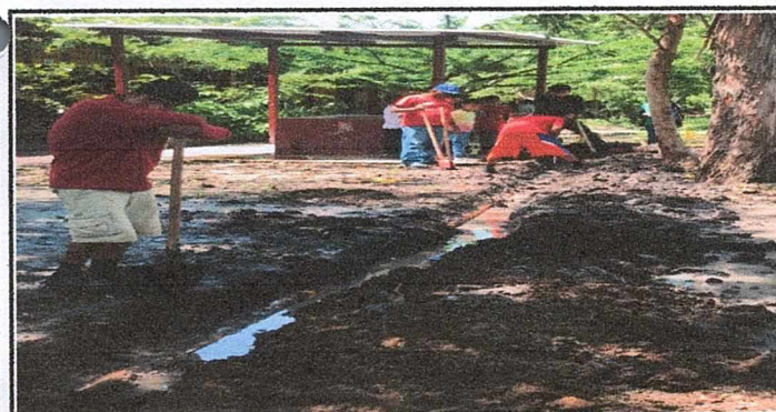
Foto 5: Colocación de tubería nueva en red de drenaje
