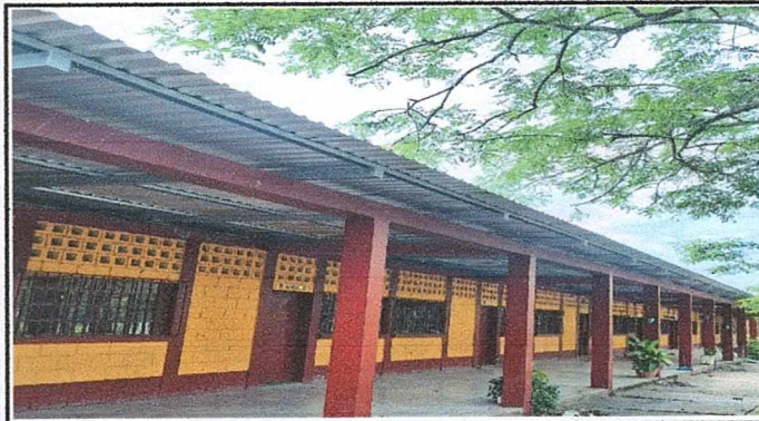
Foto 4: Colocación de techo de lámina
