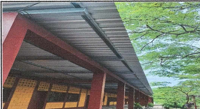
Foto 2: Colocación de techo de lámina
