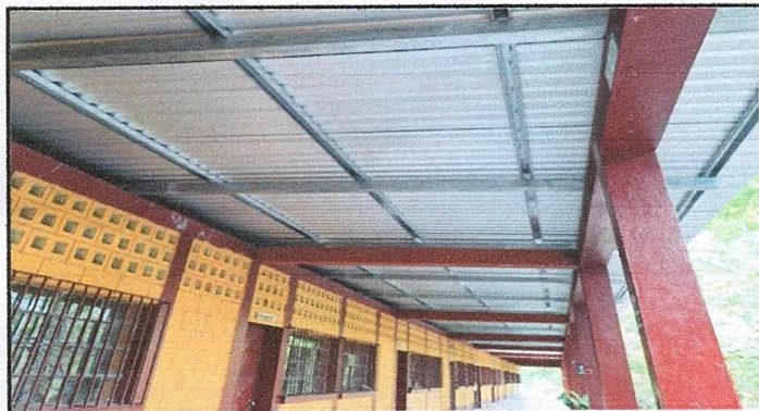
Foto 3: Colocación de techo de lámina
