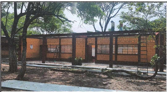
Foto 3: Desmontaje del techo de duralita
