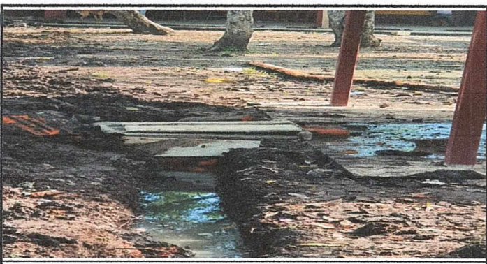
Foto 5: Construcción de nuevas cajas para la red de drenaje
