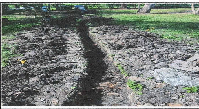
Foto 6: Sanjeo para nueva introducción de red de drenaje
