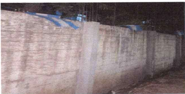
Foto 5: Reparación de muro perimetral
