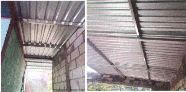
Foto1: Instalación de estructura y techo a dos aulas y pasillo
