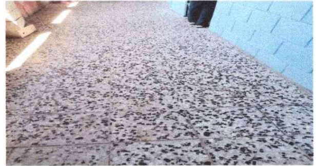
Foto 2: Instalación de piso de granito a cinco aulas y pasillos
