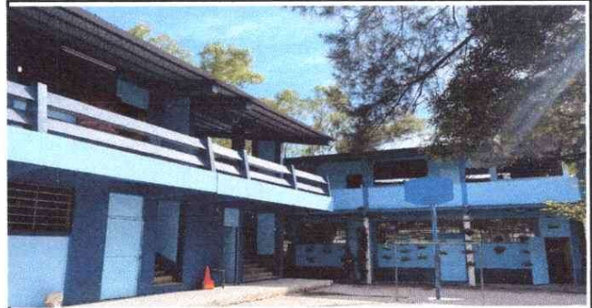
Foto 4: Pintura de exteriores
