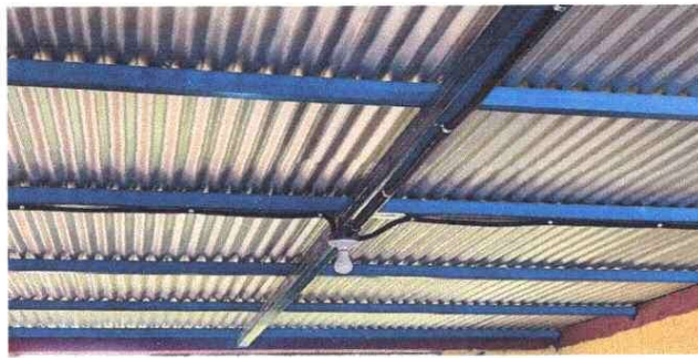
Foto 3: Instalación y reparación del sistema eléctrico y suministros
