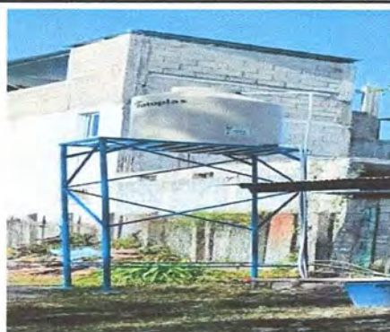
Foto 2: Instalación de tinaco
