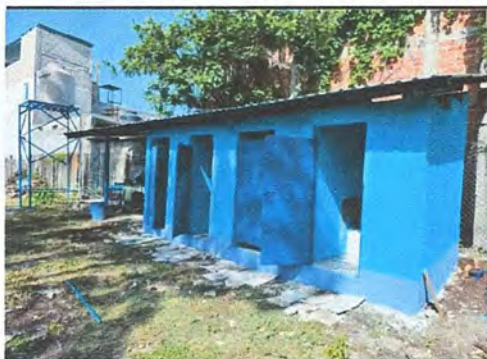
Foto 3: Remodelación en area de baños e instalacion de inodoros
