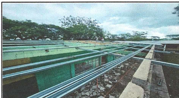
Foto 1: Instalación de estructura metálica
