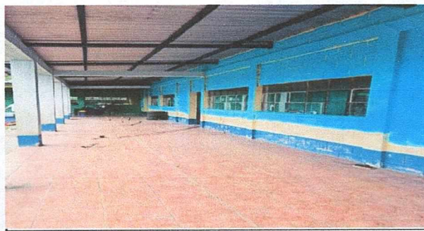
Foto 6: Limpieza de piso y paredes
