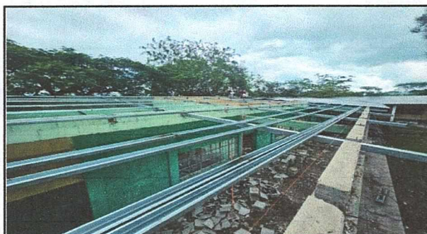
Foto 3: Instalación de lámina
