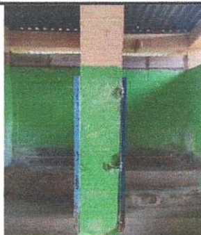
Foto 6: MANTENIMIENTO Y REPARACIÓN DE MINGITORIO
