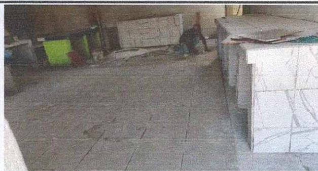
Foto 5: REPELLO, CERNIDO Y PINTURA EN MUROS INTERIORES Y EXTERIORES, MEJORAMIENTO DE PILA, INSTALACIÓN DE PUERTA Y SUSTITUCIÓN DE TORTA DE CONCRETO POR PISO CERÁMICO EN AREA DE
