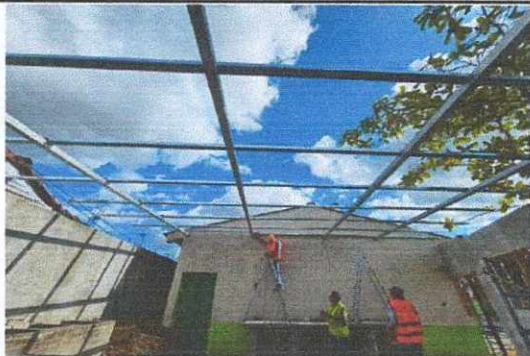
Foto1: INSTALACIÓN DE TECHO CON ESTRUCTURA METALICA Y LAMINA TROQUELADA EN MODULO DE AULAS
