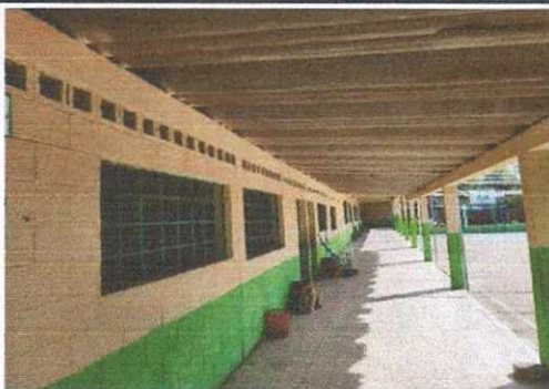
Foto1: INSTALACIÓN DE TECHO CON ESTRUCTURA METALICA Y LAMINA EN MODULO DE AULAS
