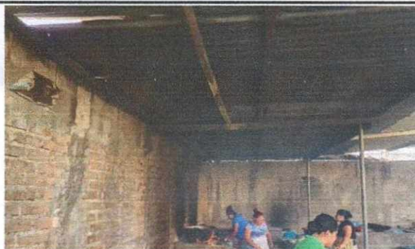
Foto 3: INSTALACIÓN DE TECHO CON ESTRUCTURA METALICA Y LAMINA EN COCINA
