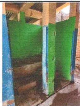
Foto 6: MANTENIMIENTO Y REPARACIÓN DE MINGITORIO
