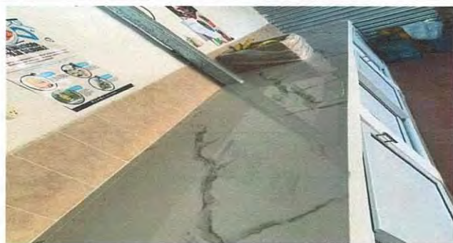
Foto 3: Mejoramiento de azulejo en mesa de trabajo de la cocina
