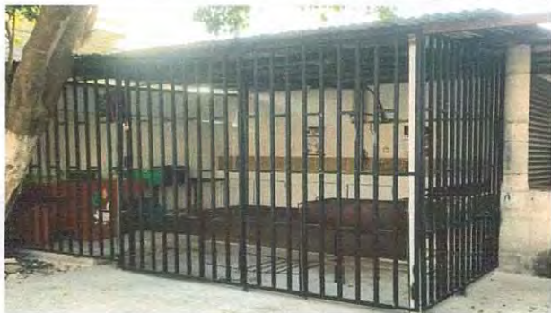
Foto1: Fabricación e instalación de rejas
