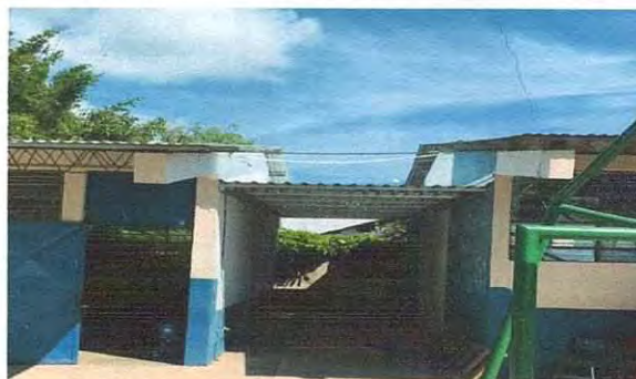
Foto 2: Colocación de techo
