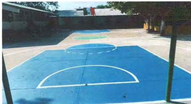
Foto 2: Señalización y pintura de la cancha.
