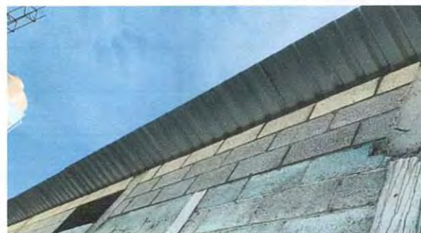
Foto 4: Levantado de muro para techo de aula.
