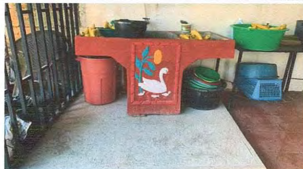
Foto 4: Mejoramiento de base para la instalación de la pila en la cocina.
