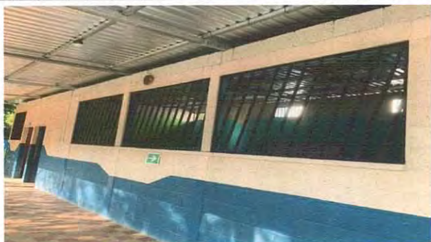
Foto 3: Mantenimiento a balcones
