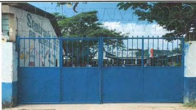
Foto 4: Mantenimiento y reparación a porton entrada principal.
