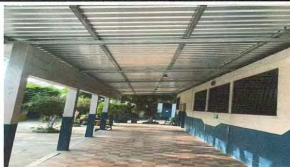
Foto 6: Sustitución de techo de lámina por lámina.
