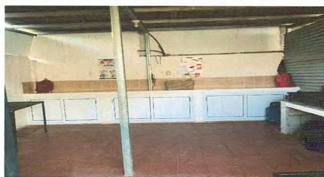
Foto 2: Sustitución de piso de concreto por piso cerámico en la cocina.
