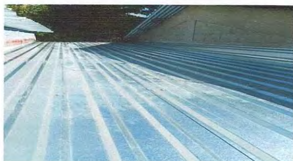
Foto1: Reparación de techo.
