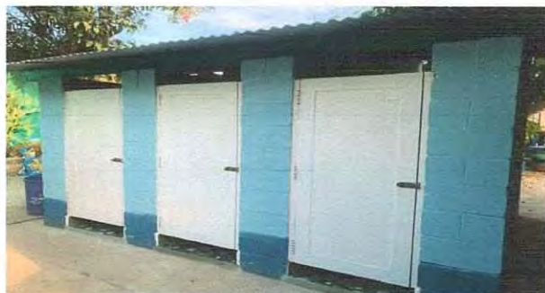
Foto 5: Sustitución de las tres puertas de metal a PVC.
