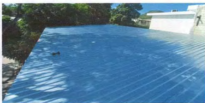
Foto 3: Sustitución de techo de lámina.
