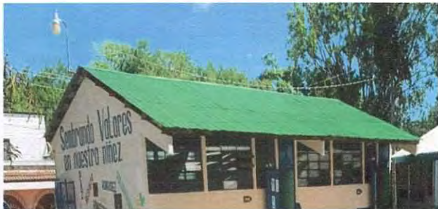
Foto 1: Mantenimiento techo con pintura aulas lado Este.
