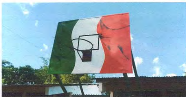
Foto 5: Mantenimiento a tableros.
