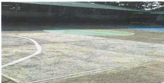
Foto1: Mejoramiento planchas de concreto
