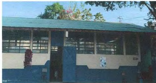
Foto 2: Mantenimiento techo con pintura aulas, lado Norte.
