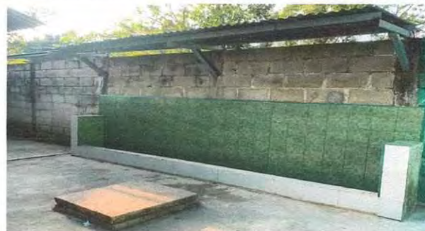
Foto 6: Mejoramiento del Urinal con azulejo.
