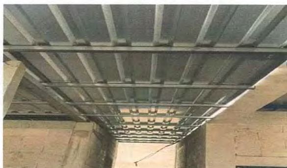
Foto 3: Reparación de techo
