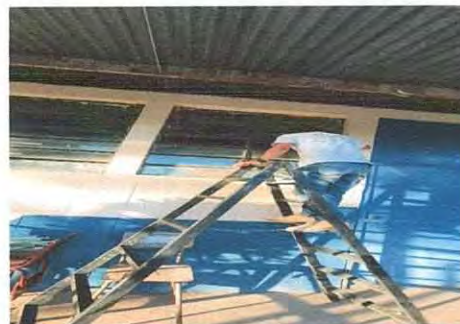
Foto 2: Sustitución de vidrios.
