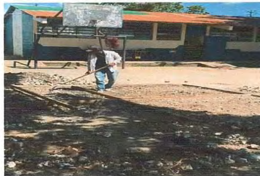
Foto 4: Mejoramiento de planchas de concreto en el patio.
