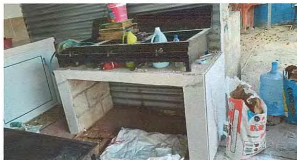
Foto 4: Mejoramiento de azulejo, en estufa de trabajo en la cocina.
