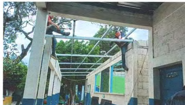
Foto 4: Mejoramiento del soporte de techo,madera por metal.
