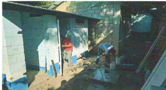
Foto 2: Sustitución de puertas de metal a PVC.
