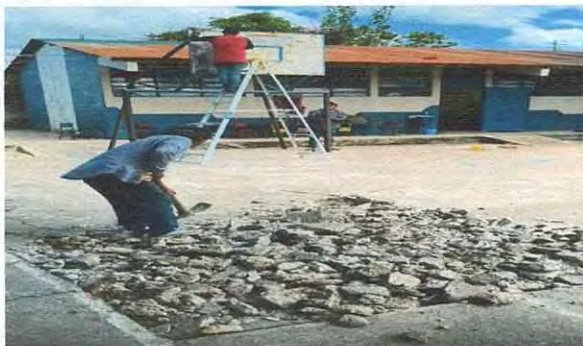
Foto 3: Mejoramiento de planchas de concreto en el patio.
