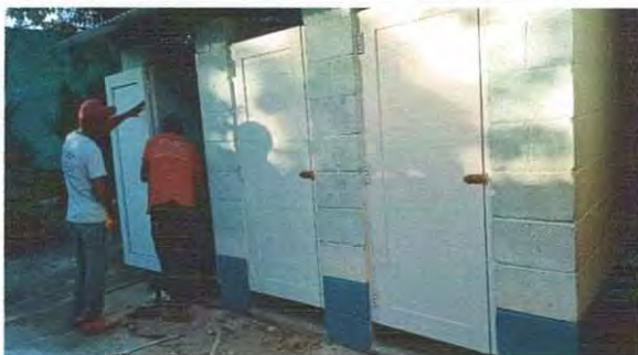
Foto 3: Sustitución de tres puertas de metal a PVC en los servicios sanitarios.
