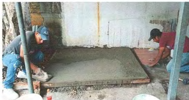
Foto 2: Mejoramiento de plancha para la base de la pila de la cocina.
