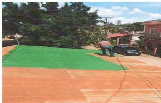
Foto 2: Mantenimiento y mejoramiento de techo de lámina con pintura, de 2 aulas, lado Este.
