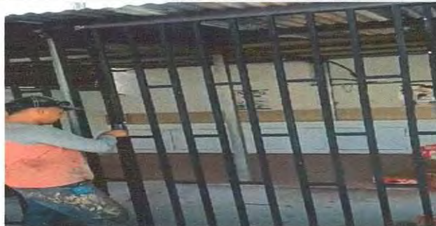
Foto 6: Instalación de rejas en la cocina.
