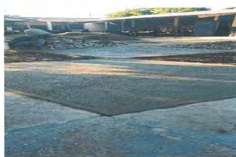
Foto 6: Mejoramiento de planchas de concreto en el patio.
