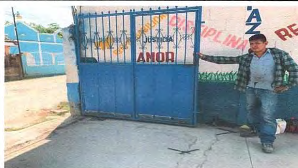
Foto 2: Reparación y mantenimiento del portón de la entrada principal.
