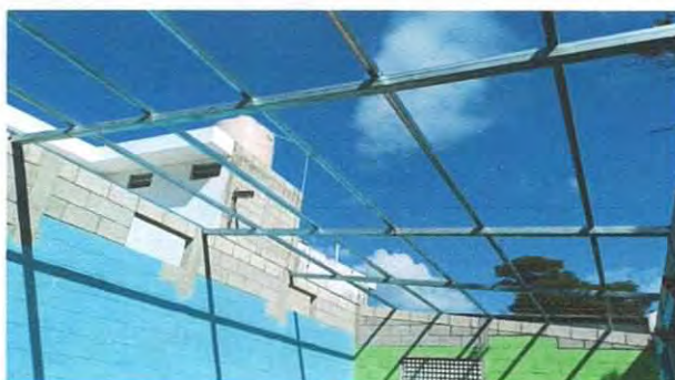
Foto 3: Mejoramiento del soporte de techo,madera por metal.
