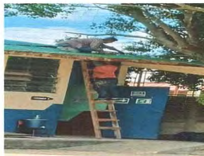
Foto 4: Mantenimiento y mejoramiento de techo de lámina con pintura de 2 aulas lado Norte.
