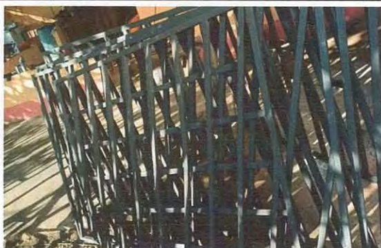
Foto 3: Mantenimiento a balcones.
