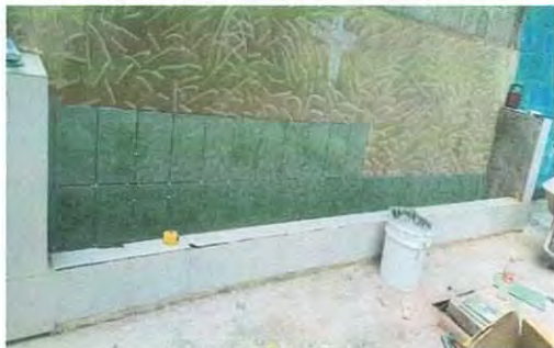
Foto1: Mejoramiento en la instalación de azulejo en el urinal.
