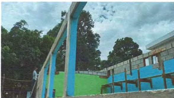
Foto1: Sustitución de techo de lámina por láminaMejoramiento de muro para la altura del techo.
