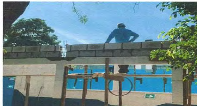
Foto 2: Mejoramiento de muro para la altura del techo.
