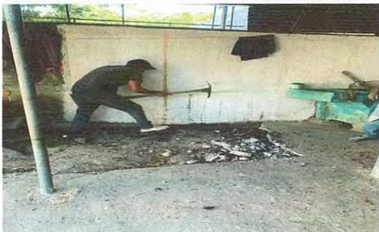
Foto1: Mejoramiento para la base de la pila de la cocina.
