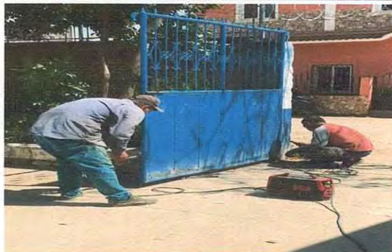
Foto1: Reparación y mantenimiento del portón de la entrada principal.
