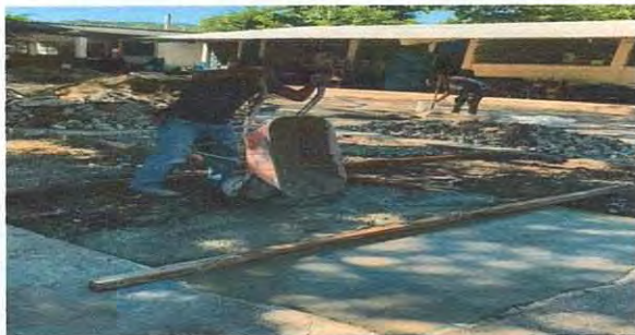
Foto 5: Mejoramiento de planchas de concreto en el patio.
