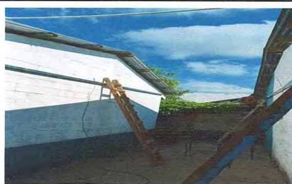
Foto 4: Mejoramiento e instalación de techo.
