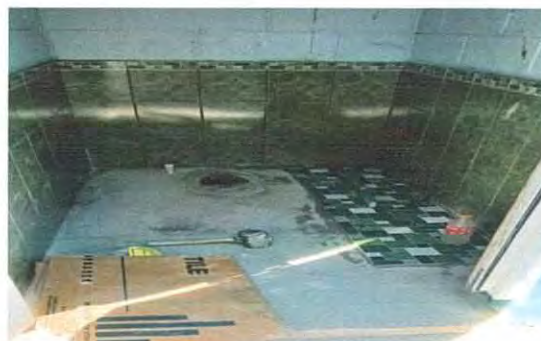
Foto 4: Mejoramiento de azulejo y piso antideslizante en los sanitarios.
