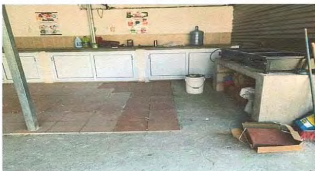
Foto 3: Mejoramiento de piso antideslizante en la cocina.
