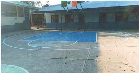
Foto1: Mejoramiento y restauración de pintura para señalización de cancha.
