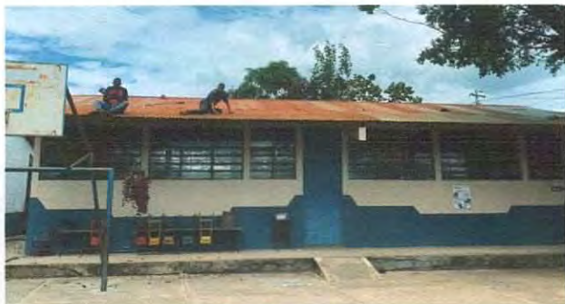
Foto1: Mantenimiento y mejoramiento de techo de lámina con pintura de 2 aulas lado Norte.
