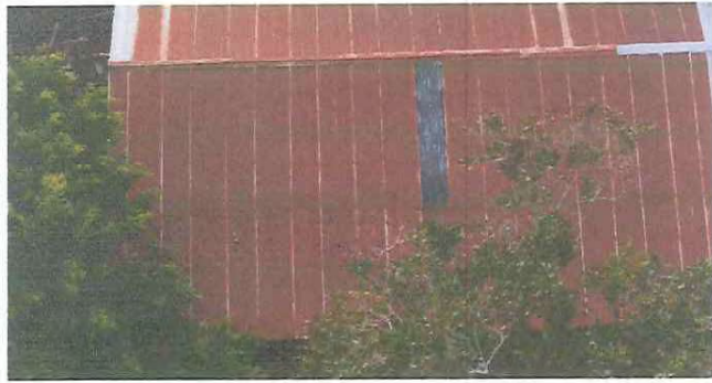
Foto1: Vista aérea del techo a sustituir.
