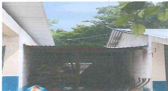
Foto 1: reparación de techo.
