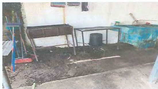
Foto 4: mejoramiento de piso.
