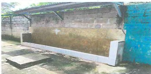
Foto 3: mejoramiento de azulejo en el urinal.
