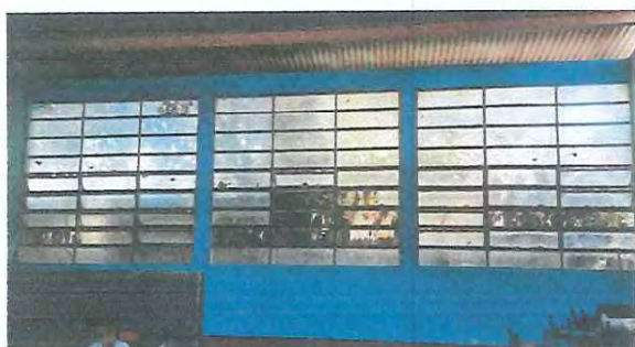
Foto 5: sustitución de vidrios.
