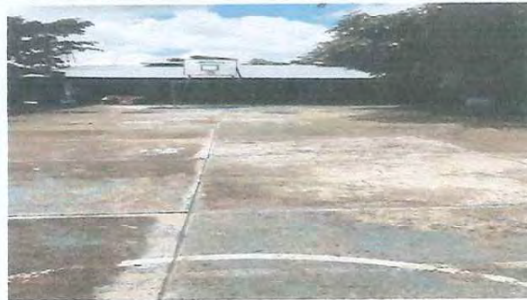
Foto 4: pintura para cancha
