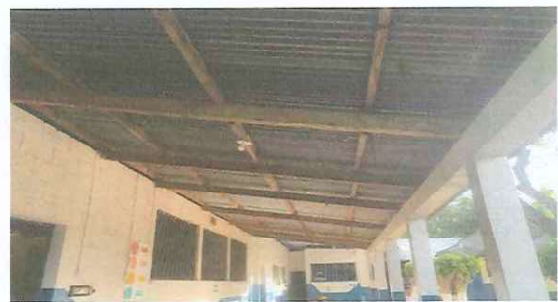
Foto 6: Corredor del aula.
