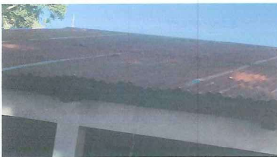
Foto 5: Vista frontal del aula.
