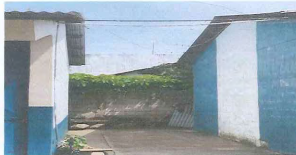
Foto 2: colocación de techo
