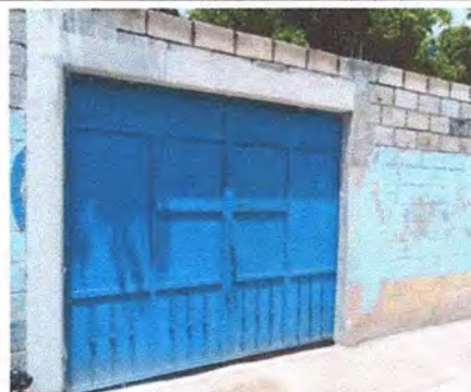
Foto 8: MEJORAMIENTO DE PORTON DE ACCESO
