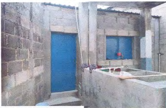
Foto 3: INSTALACIÓN DE PUERTA, VENTANA, PISO Y PILA EN COCINA
