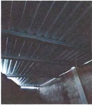
Foto 1: INSTALACIÓN DE TECHO CON ESTRUCTURA METALICA Y LAMINA TROQUELADA
