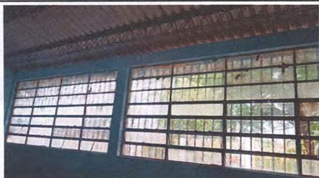
Foto 9: SUSTITUCIÓN DE VIDRIOS EN VENTANALES
