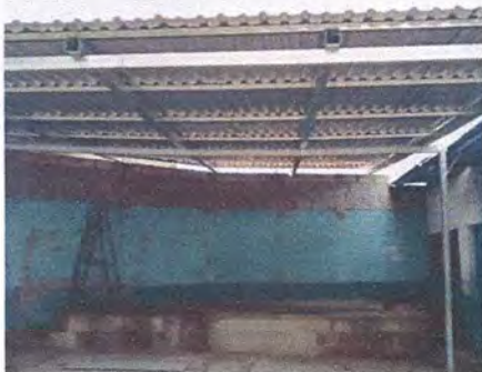
Foto 5: MEJORAMIENTO DE TECHO CON ESTRUCTURA METALICA Y LAMINA TROQUELADA Y PAREDES DE BLOCK EN PATIO
