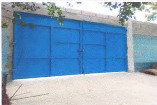
Foto 7: MEJORAMIENTO DE PORTON DE ACCESO
