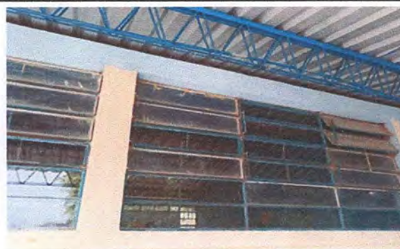
Foto 10: SUSTITUCIÓN DE VIDRIOS EN VENTANALES
