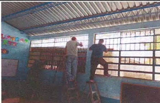
Foto 8: SUSTITUCIÓN DE VIDRIOS EN VENTANALES
