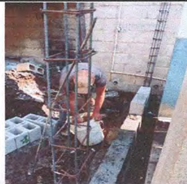
Foto 2: MEJORAMIENTO EN PARED DE BLOCK Y ESTUFA RURAL EN COCINA
