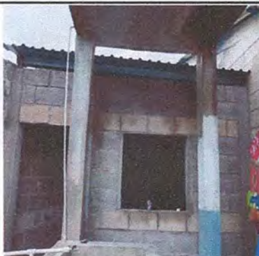
Foto 3: INSTALACIÓN DE PUERTA, VENTANA, PISO Y PILA EN COCINA
