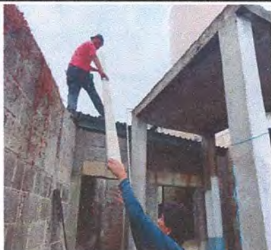
Foto1: INSTALACIÓN DE TECHO CON ESTRUCTURA METALICA Y LAMINA TROQUELADA
